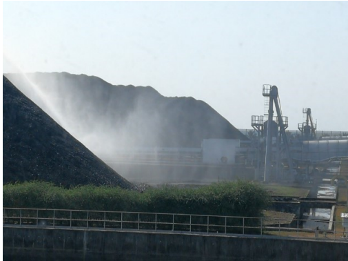
รูปที่ 3 การฉีดพรมน้ำบริเวณลานกองถ่านหิน และสายพานลำเลียงถ่านหิน
